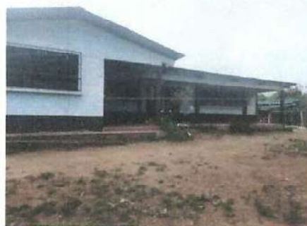
Foto 2: Estructura y cubierta tipo lamina troqueada para al entrada
