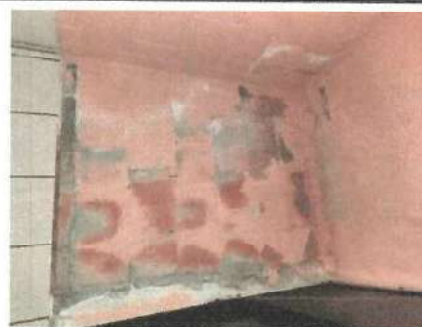
Foto 4: Remorzamiento para piso area de cocina
