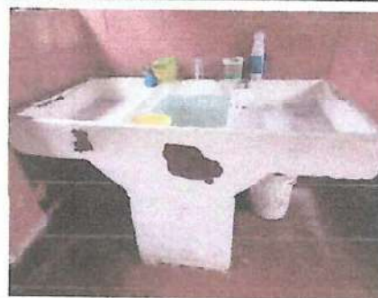
Foto 6: Remorzamiento de pila area de cocina
