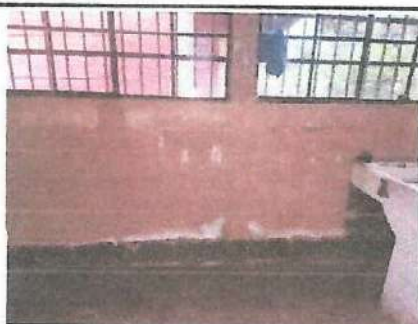
Foto 5: Remorzamiento de pila area de cocina
