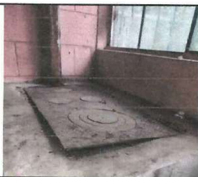
Foto 5: Mejoramiento de cocina
